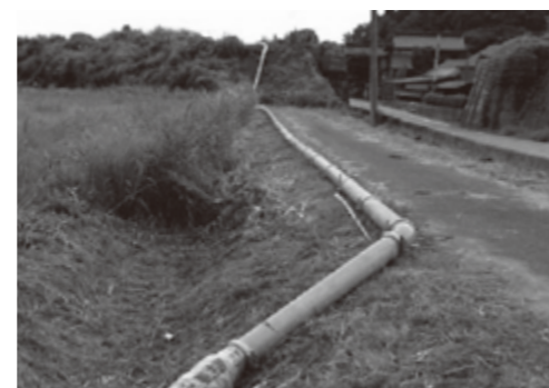
▲山田川（小垣付近）から仮設送水管を敷設（9/4）
