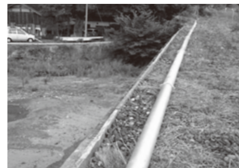
▲仮設送水管は線路跡を通過して寺田川へ（9/4）
