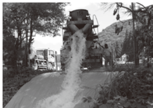
▲コンクリートミキサー車6台で原水を運搬（8/24）
