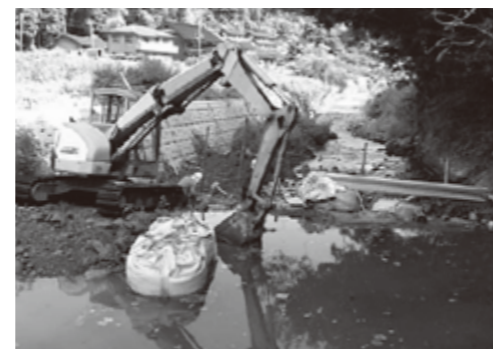
▲矢波浄水場取水口付近のせき止め工事（8/24）
