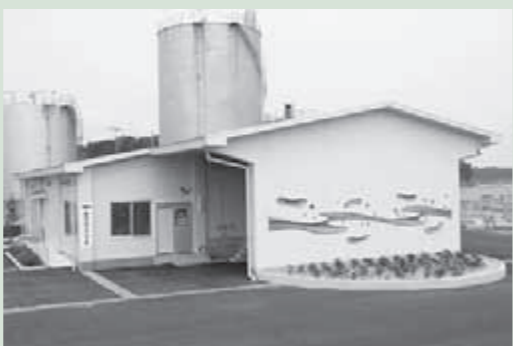
小木にある能登海洋深層水取水施設
