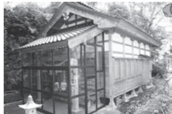
⑤町野川沿いに立つ社殿は洪水でたびたび流され、現在の地に落ち着いた
