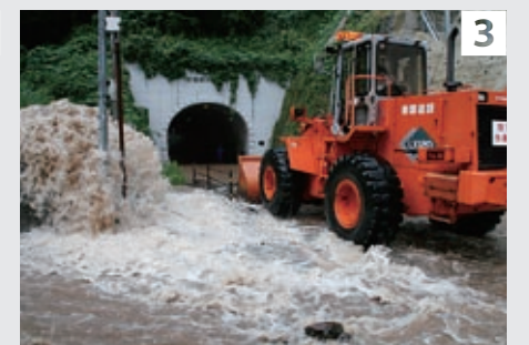
③ 宇出津第1トンネル前では上部の住宅地から大量の雨水が流れ、側溝から噴出した
