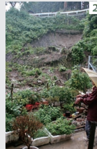
② 宇出津塩谷寺参道の急傾斜ががけ崩れ、土砂が民家裏の畑に流れ込んだ
