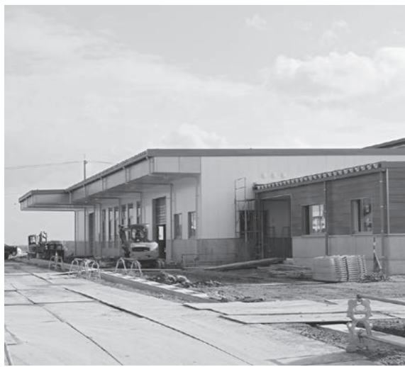
※宇出津港水産物加工処理施設
