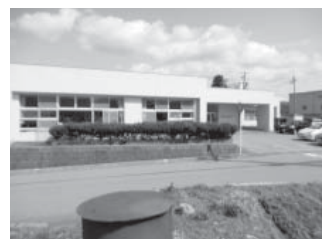
解体されるひばり保育所
