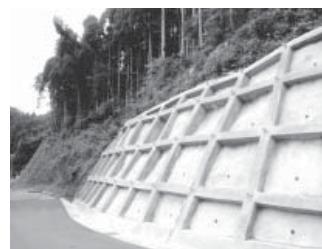
町道法面工事
