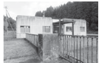
解体される漆原浄水場
