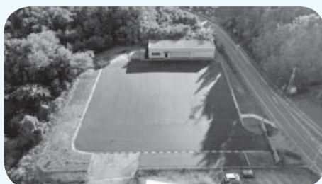
解体した内浦クリーンセンター跡地
