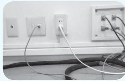
宅内 LAN 配線工事 (イメージ)
