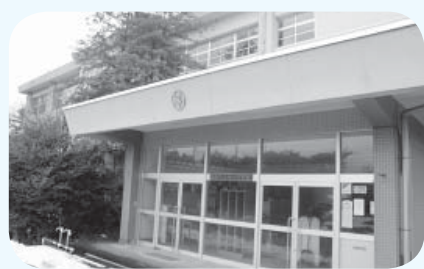
解体が予定されている旧鵜川小学校
