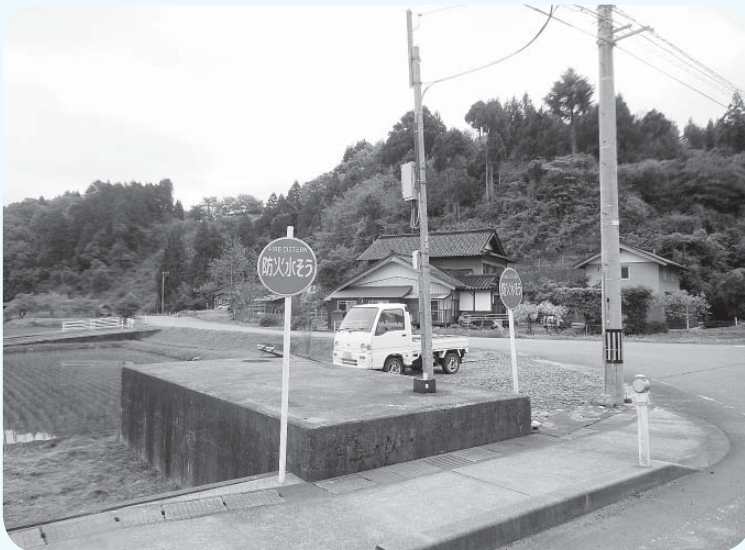
交差点付近に設置されている防火水槽
