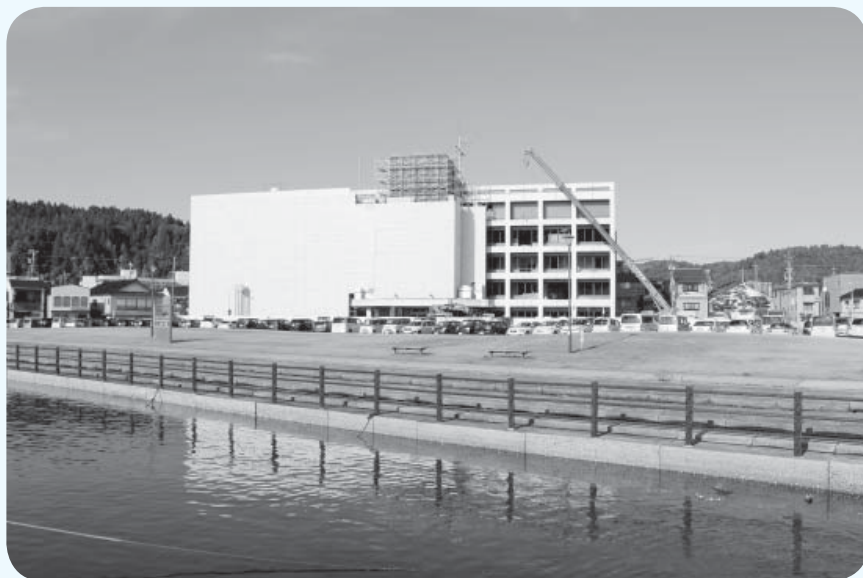
解体工事が進められる旧能都庁舎
