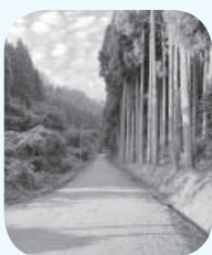
除草作業を終えた道路
