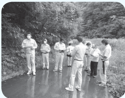
林道河ヶ谷線舗装工事
