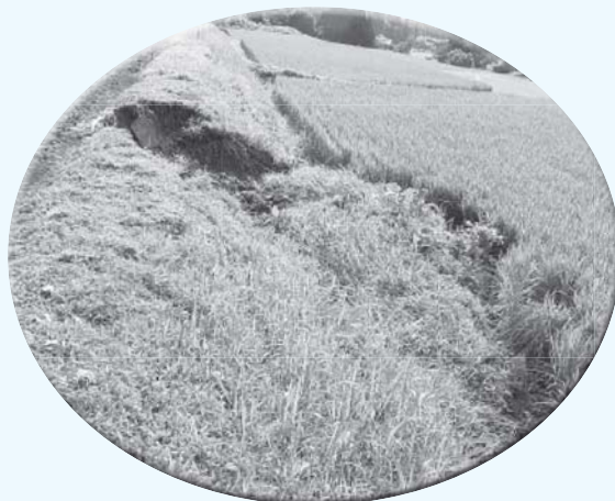
豪雨により崩落した農地 (坪根地内)
