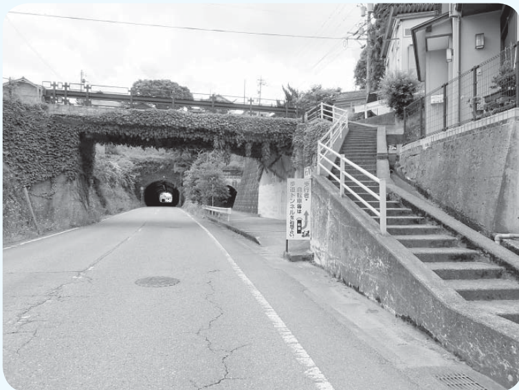
町が設置した誘導看板
