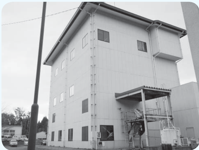
老朽化により解体される内浦クリーンセンター
